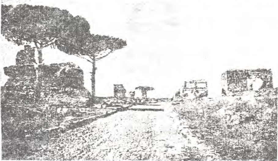
شكل (٨٨) الطريق الايباني
