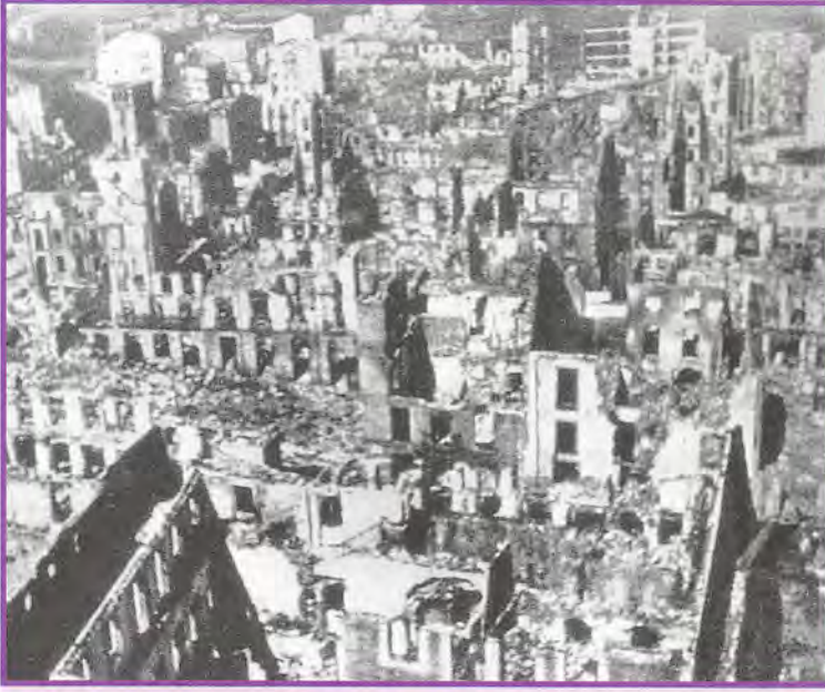
▲ آثار كارثة قصف "جويرنيكا"، 1937، لقد أصبحنا معتادين على رؤية صور لمثل هذا الدمار، ولكن في 1937 كان ذلك صادمًا.
