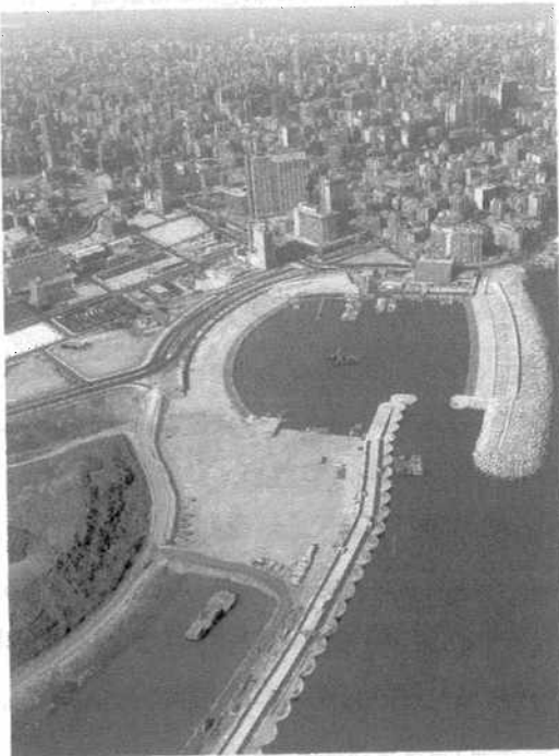
الواجهة البحرية بعد أعمال الردم (صورة جوية).
