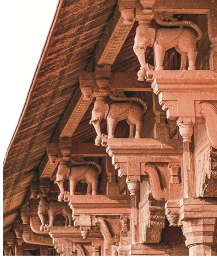
تقنيات هندية لإدعامات الجدران corbelling technique
