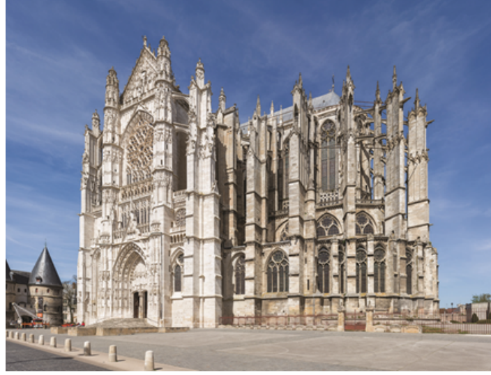
صورة لما بقي صامداً من كاتدرائية بوفيه في بيكاردى بعد انهيار صحنها.
